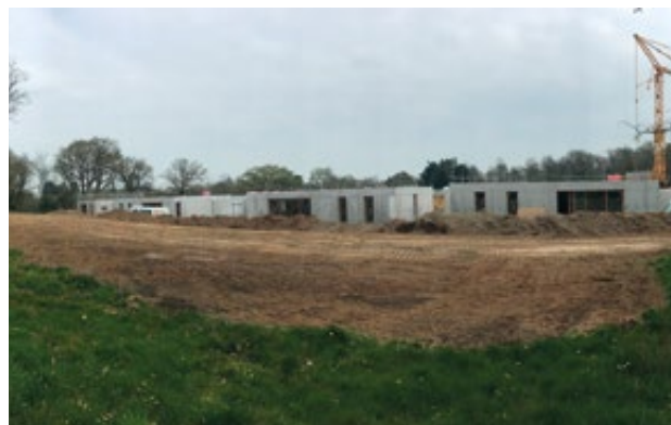
Les travaux au Lion d'Angers
